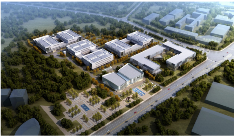
大数据中心外立面鸟瞰图
